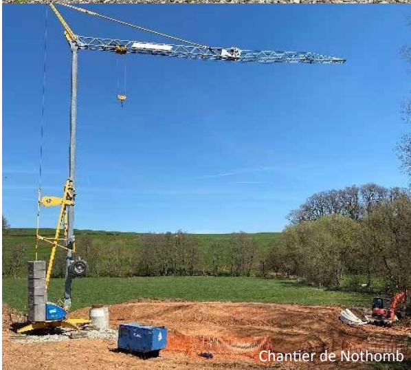
Chantier de Nothomb
