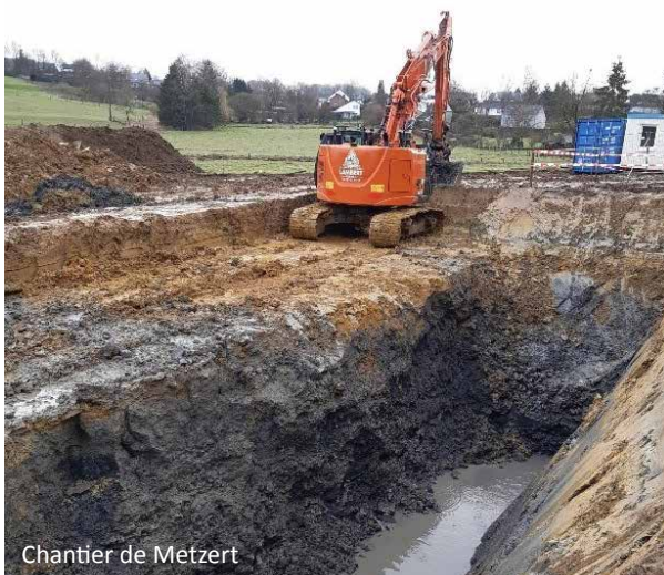
Chantier de Metzert
